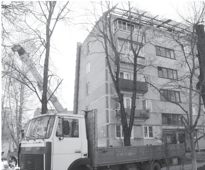
Замена крыши дома № 6 по улице Гагарина.
